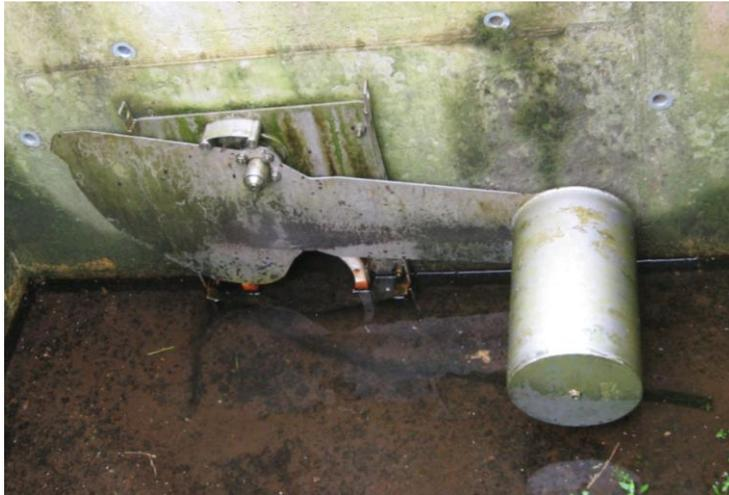
**Figure 14 : Vanne de régulation du débit à 40 l/s en sortie du bassin**
