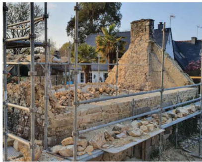
Ty Chan, au début des travaux
